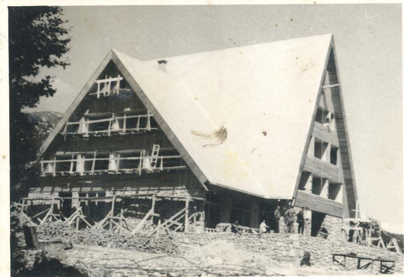
6. Izgradnja hotela Velebno na Baškim Oštarijama početkom sedamdesetih godina 20. stoljeća
