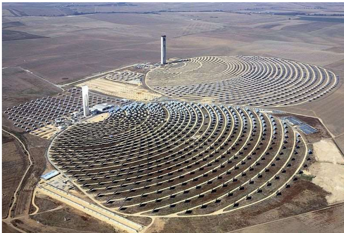
Solarna elektrana s tornjevima u Andaluziji, snage 11 MW
