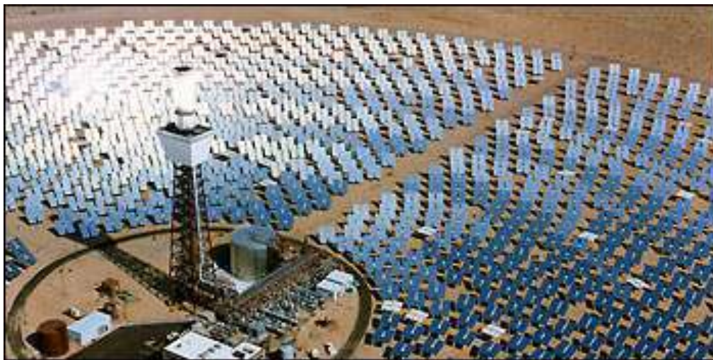
"Power Tower" konfiguracija zrcala (Španjolska) fokusira Sunčevu energiju prema vrhu tornja.
