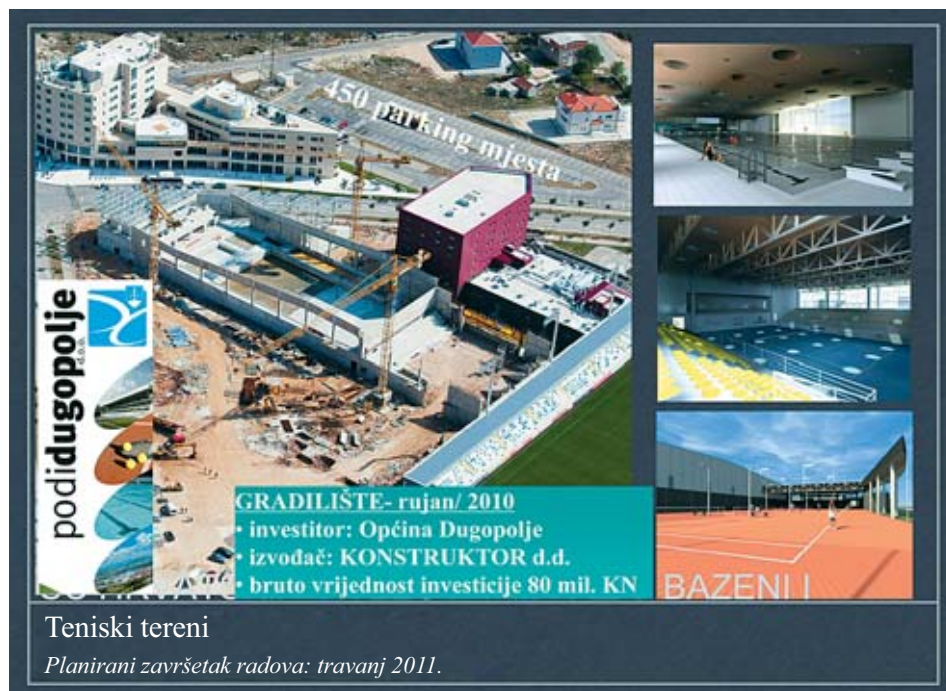
Slika 7. Teniski centar u izgradnji
