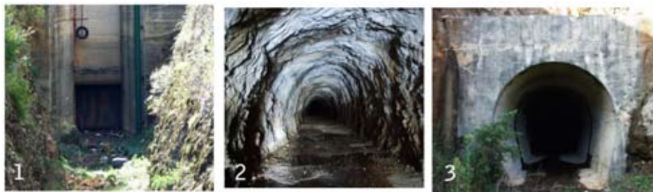
Slika 9. Odvodni tunel Rastok: 1 – ulazni otvor u polju Rastok, 2 – unutrašnjost tunela, 3 – izlazni otvor u Vrgorskom polju
