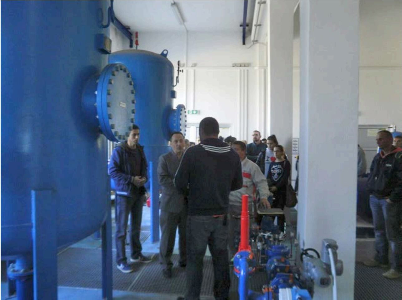
Slika 11. Terenska nastava na Sveučilišnom dobru Baštica, pogonski dio sustava za navodnjavanje
