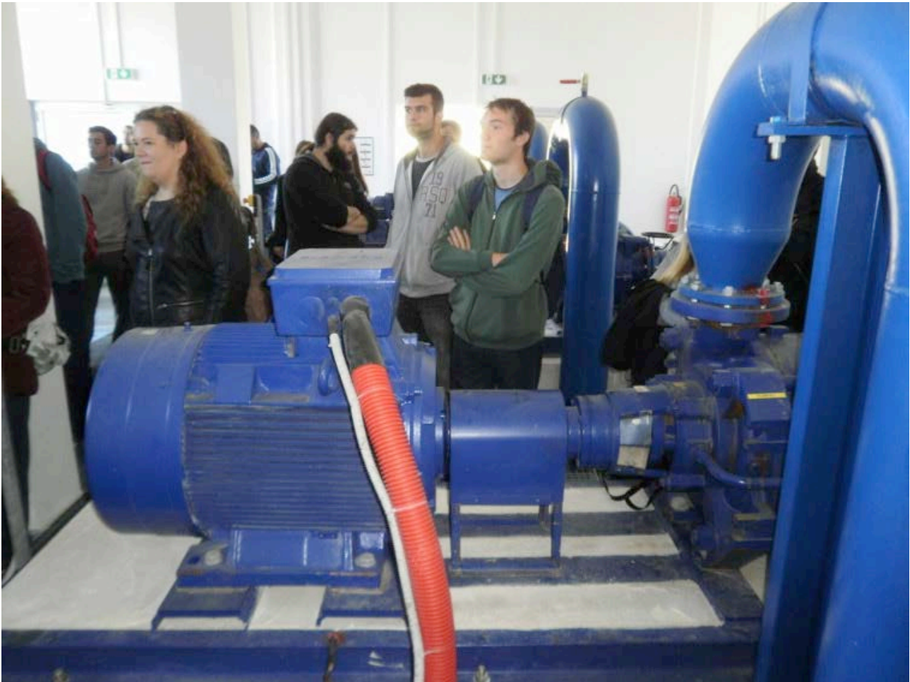
Slika 10. Pumpe za navodnjavanje na sustavu Baštica
